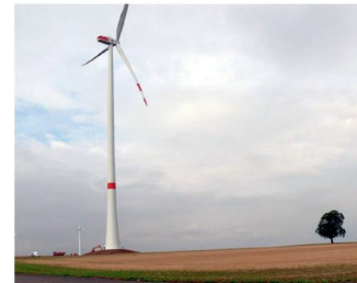
Figure 2-1 : Éoliennes – combien d'infrasons génèrent-elles ? Photo : Ets. Wölfel.
